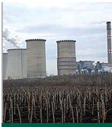
Hazánk legkorszerűbb, kombinált gáz-, gőzturbinás erőműve
